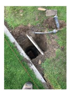
Punktfundamente für Pfosten erstellen.
